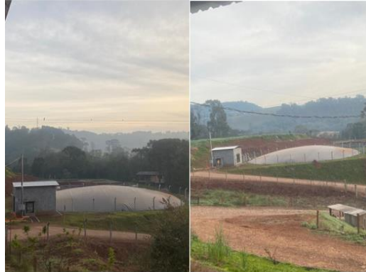
Figura 1 – Visão geral do biodigestor
