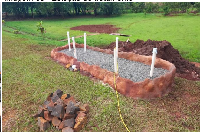
imagem 06 - Estação de tratamento
