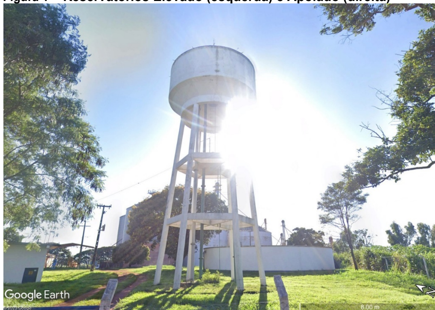
Figura 1 – Reservatórios Elevado (esquerda) e Apoiado (direita)
