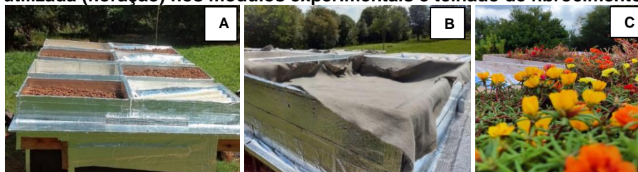
Figura 3- Procedimento de construção, vedação e implantação das coberturas de vegetação no ano 2: A) construção dos módulos experimentais; B) instalação da manta geotextil e do substrato para implantação do telhado verde; c) bancada experimental com telhado verde com plantio da espécie utilizada (floração) nos módulos experimentais e telhado de fibrocimento.
